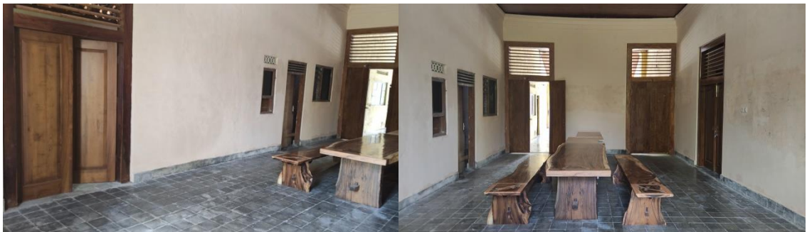
Gambar 17. Pintu-pintu tiap ruangan yang mengalami pemugaran rehabilitasi. Sumber: dokumentasi pribadi Afiliasi Ilafi
